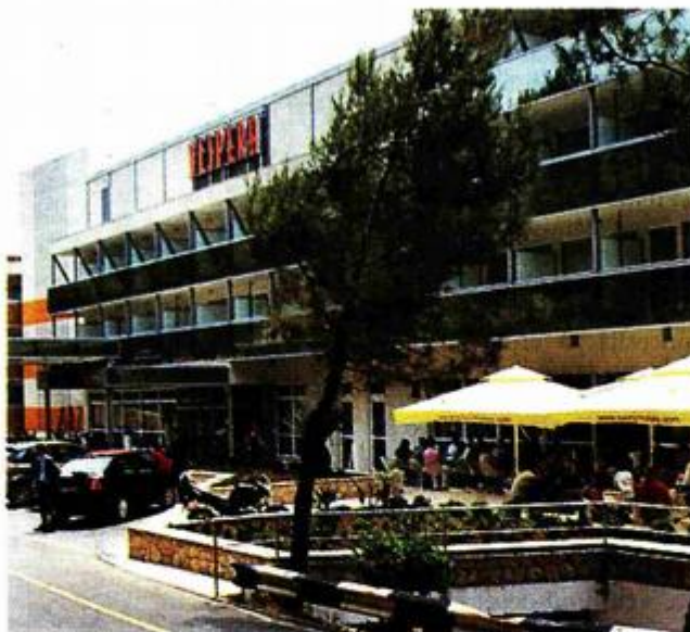
Hotel Vespera čija je rekonstrukcija dovršena u svibnju
